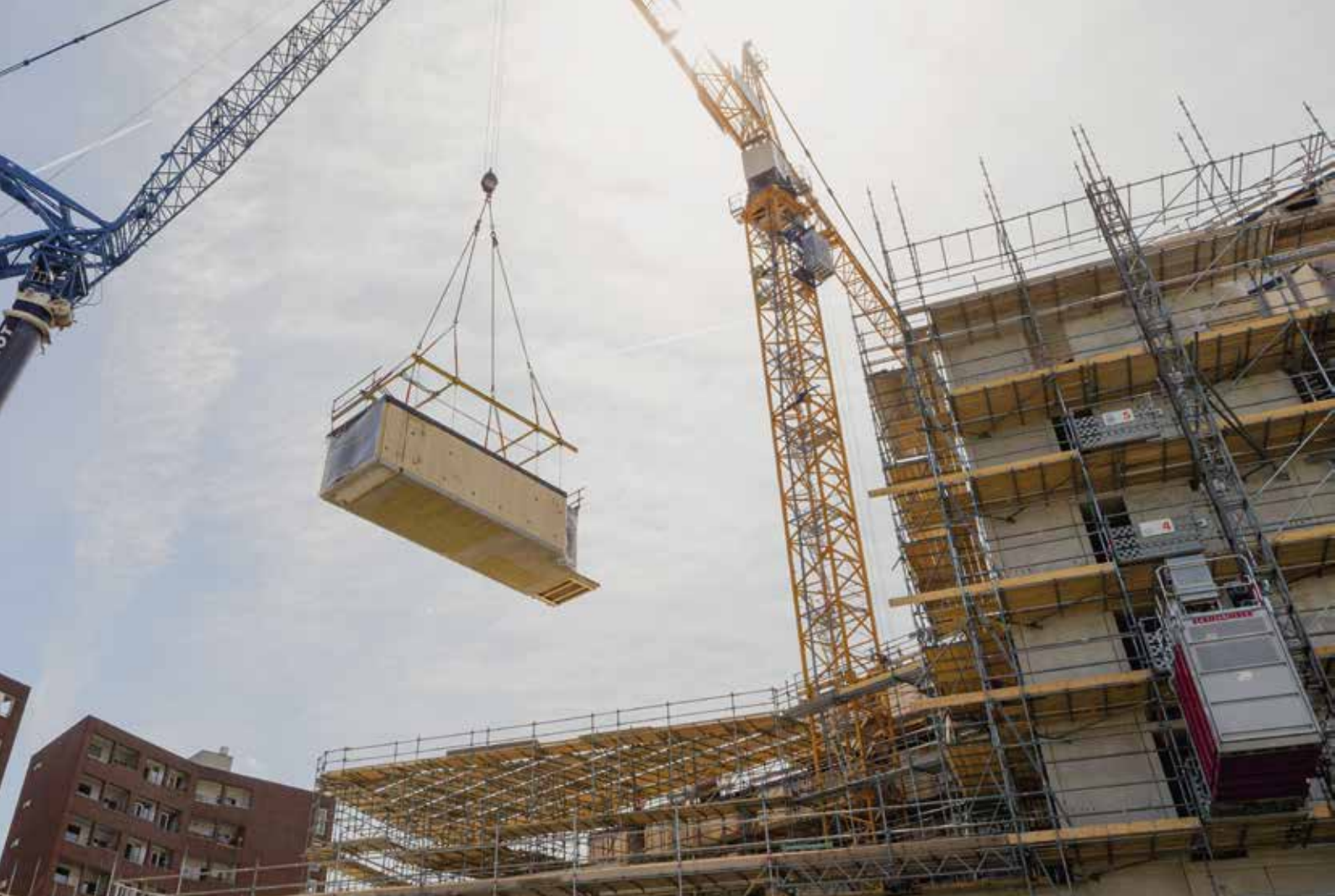
Vorgefertigte Elemente können die Effizienz steigern und die Kosten senken, wie bei diesem Hotelprojekt in Amsterdam (NL).
